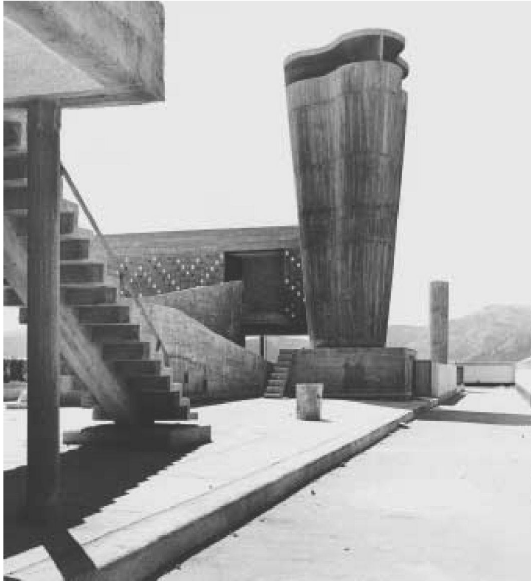
Dachlandschaft der Unité d'habitation in Marseille, 1946–1952
